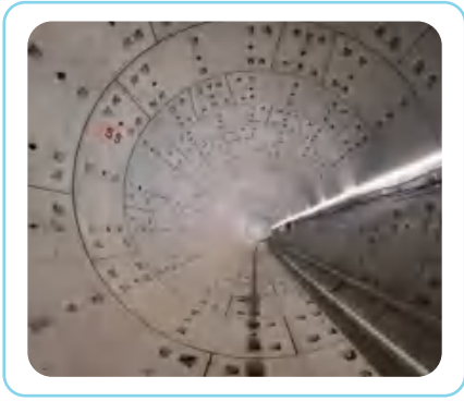
北京轨道交通 13号线扩建提升工程
