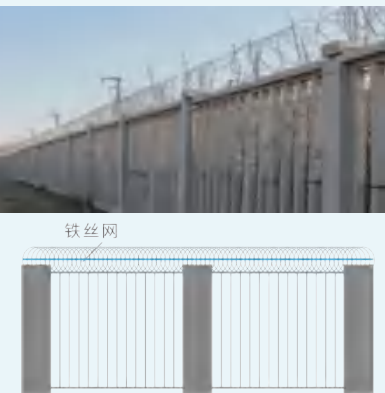
绑扎在滚刺网内，U字型铺设
