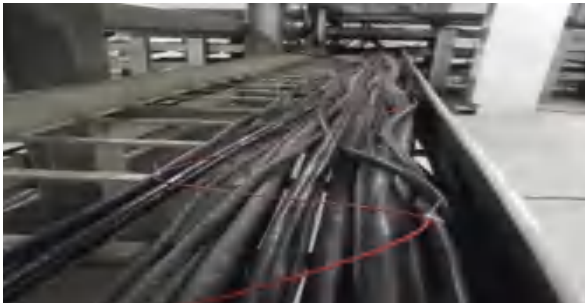
电力电缆波浪型铺设
