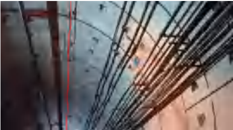
地铁隧道—Z 字型铺设
