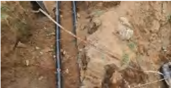
热力管道上方随管道铺设
