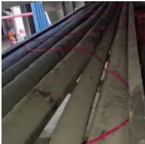
管廊电缆波浪型铺设
